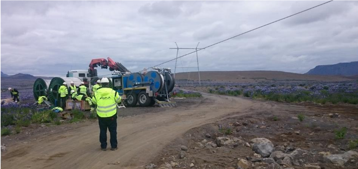
MYND 4-11 Strenging leiðara. Myndin er frá byggingu Kröflulínu 4.
