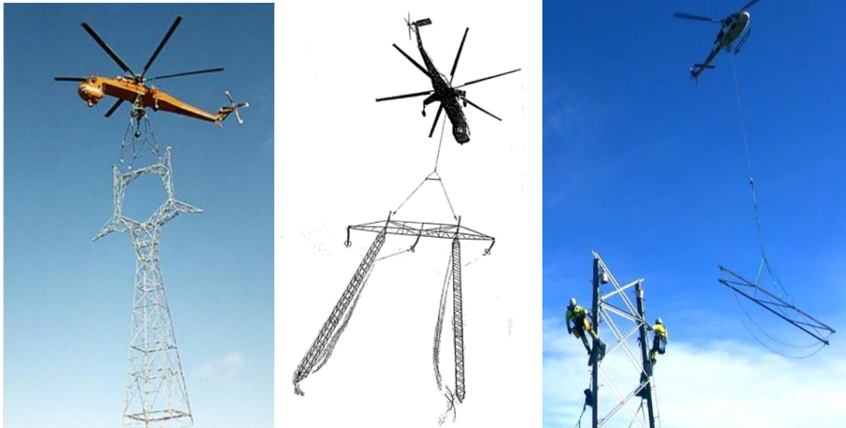
MYND 4-34 Reising masturs með Erickson þyrlu (lyftigera 11 tonn), mastur í stórum hlutum (til vinstri). Flutningur á 400 kV mastri í Svíþjóð (fyrir miðju). Reising hjá Statnett í Noregi, mastur hift í hlutum með lítilli þyrlu (lyftigeta um 1 tonn) (til hægri).
