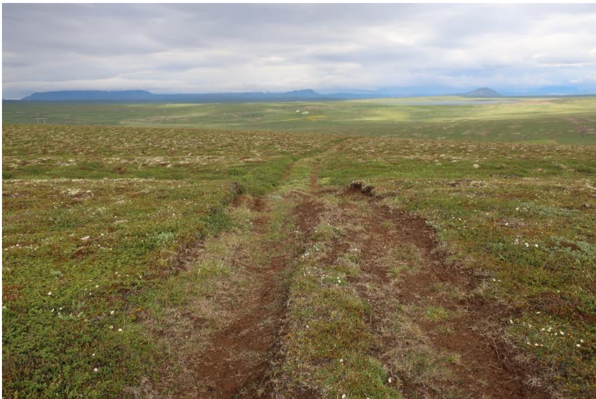
MYND 4-28 Dæmi um slóð eða troðning sem þarfnast mikillar styrkingar, í grennd við Stafn í Reykjadal, horft austur.
