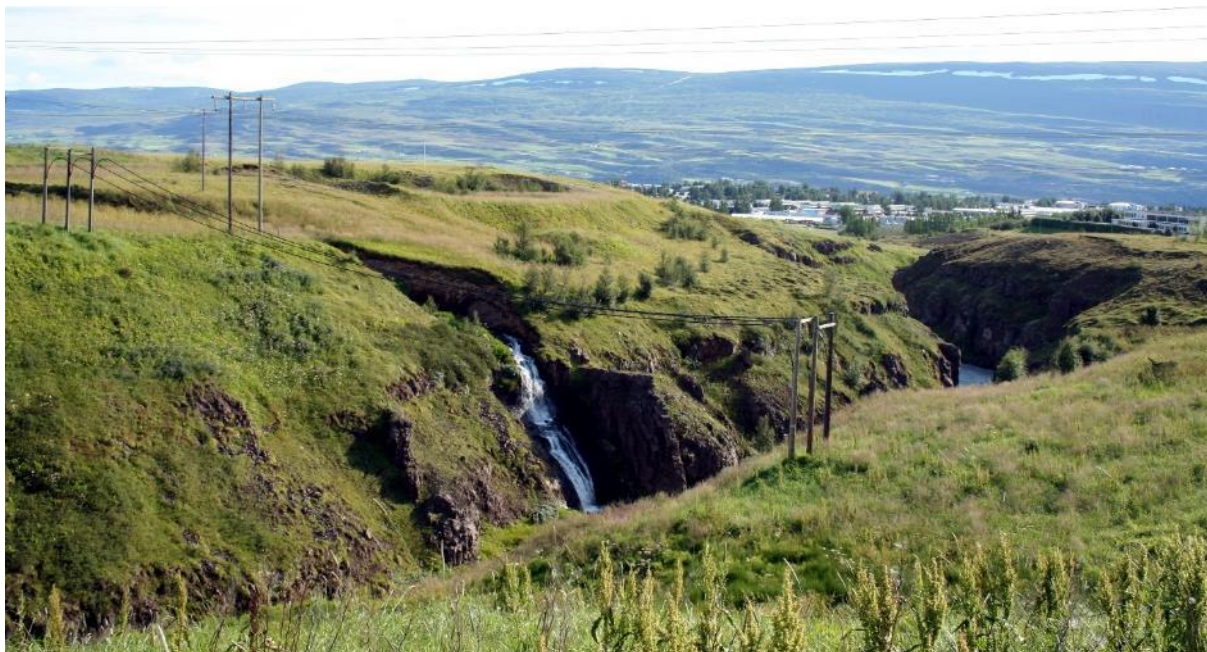
MYND 6-1 Glerárgil. Á myndinni sést þverun núverandi raflína, Kröflulínu 1 og Laxárlínu 1, og jarðstrengja RARIK. Þverun aðalvalkostar á strengjabrú er um 60 m neðan við neðri loftlínuna.
