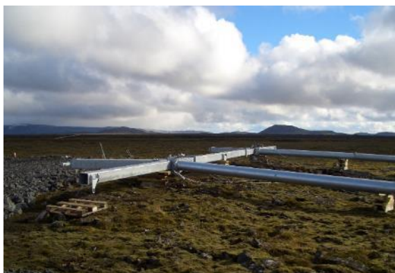
MYND 4-10 Myndir sýna vinnu við samsetningu og reisingu stagaðs burðarmasturs af M-gerð með jarðvírseyrum. Myndirnar eru frá byggingu Reykjaneslínu 1.
