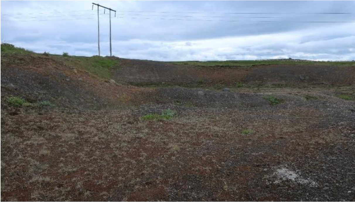
MYND 4-52 Kröflulína 1, fyrsta mastur neðan Þjóðveggar 1. og gamalt efnistökusvæði við afleggjara að Víðum.
