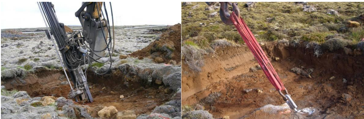
MYND 4-9 Til vinstri sést hvar borað er fyrir bergbolta. Myndin til hægri sýnir bergboltaprófun.
