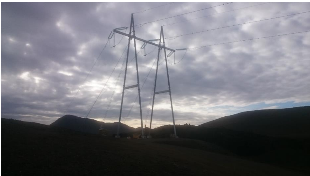
MYND 4-7 Frístandandi hornmastur sem kemur til greina að nota á nokkrum stöðum í línunni í stað stagaðra súluhorna. Myndin er af fastmastri, með jarðvísreyru, í Kröflulínu 4.
