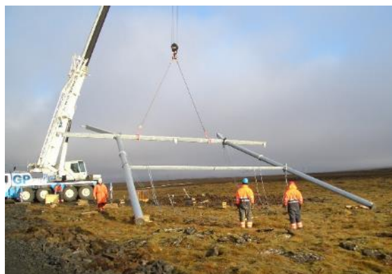
MYND 4-10 Myndir sýna vinnu við samsetningu og reisingu stagaðs burðarmasturs af M-gerð með jarðvírseyrum. Myndirnar eru frá byggingu Reykjaneslínu 1.
